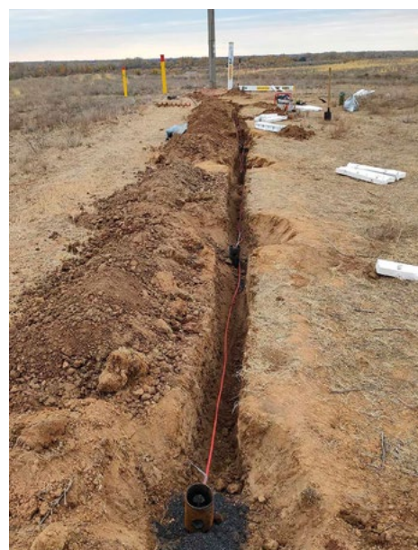
Установленное анодное заземление с использованием винтовых свай
