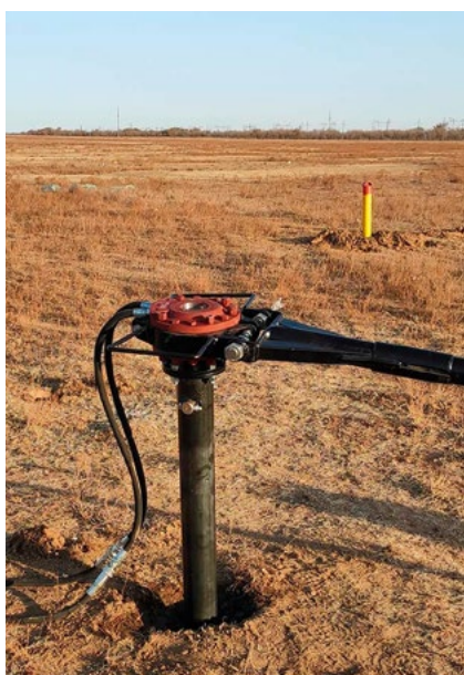
Гидровращатель (гидравлический сваекрут)
