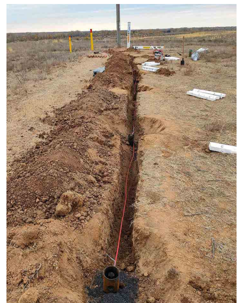
Установленное анодное заземление с использованием винтовых свай
