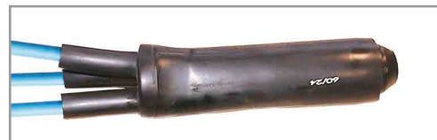
Изоляция кабельного соединения термоусаживаемыми муфтами
